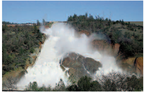
Đập Orivelle bị vỡ.
