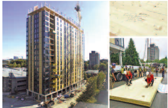
Thi công làm nhà gỗ từ các tấm CLT.
