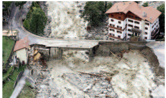
Lũ lụt tàn phá các công trình xây dựng, hạ tầng đô thị.
