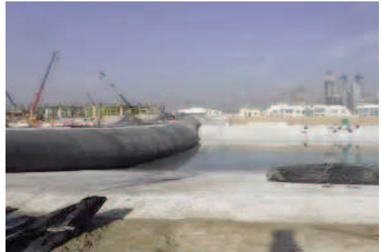
Đập Cofferdam chứa đầy nước.
