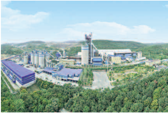
Mô hình nhà máy sản xuất xi măng tại Trung Quốc.
