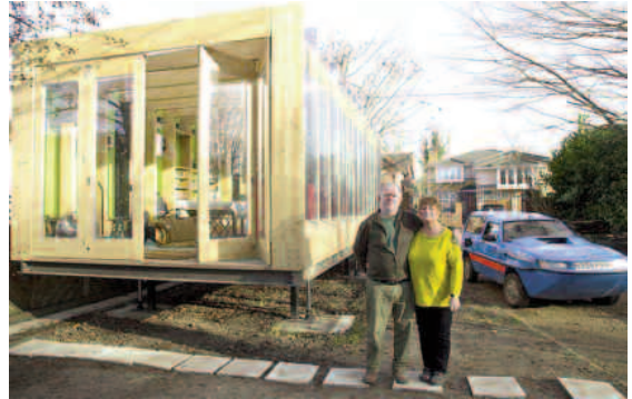
Nhà kính tự nâng lên cao nhờ hệ thống "chân" thủy lực khi xảy ra ngập lụt - thiết kế của Between Art & Technology Studio.
