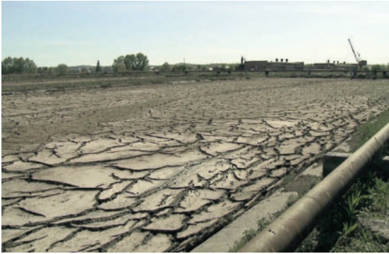
Cặn lắng (bùn thải) tại một nhà máy xử lý nước thải
