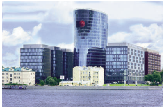
Những công trình hiện đại trong trung tâm lịch sử
