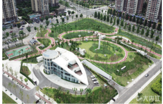
Nhà máy nước tái chế sông Tạ Gia (Nội Giang, Tứ Xuyên)
