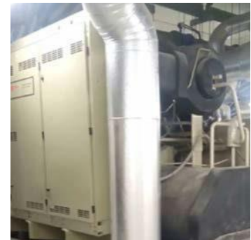
Hệ thống làm lạnh bằng nước biển
