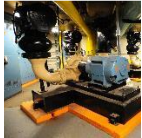
Nâng cấp hệ thống điều hòa trung tâm Chiller
