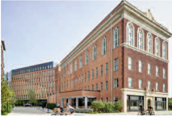
Mặt hướng ra đường của Khách sạn Pittman ở Dallas có tường chắn mái có ốp, 2 mặt bên cạnh sử dụng tường chắn mái phẳng.
