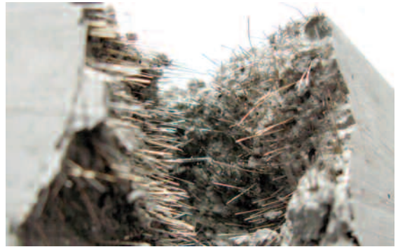
Bê tông cốt sợi.
