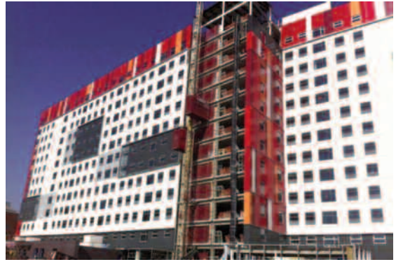
Tấm ốp panels đúc sẵn đặc biệt hữu ích cho các dự án cải tạo năng lượng sâu.
