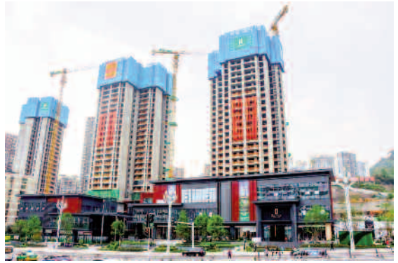
Nâng cấp các công trình xây dựng tại Đạ Châu.
