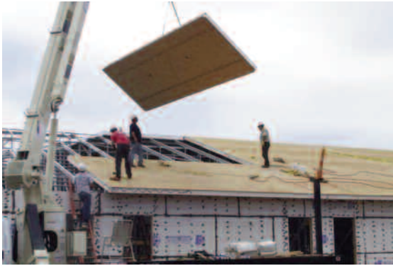
Vật liệu xây dựng đúc sẵn tạo ra ít chất thải hơn, rút ngắn thời gian xây dựng và giúp giảm chi phí dự án.
