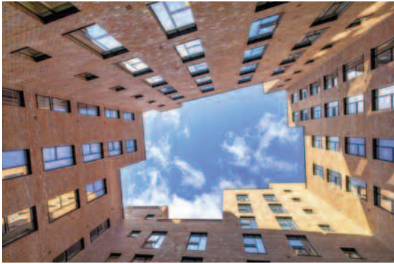
Việc sử dụng CLT tại Dalston Works ước tính đã loại bỏ được 80% lượng chất thải tại chỗ và rút ngắn thời gian thi công khoảng tám tháng.
