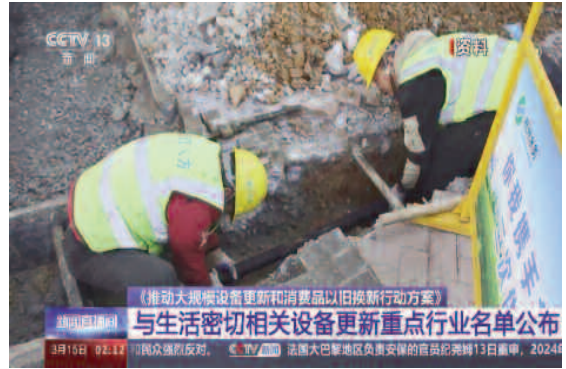
Cải tạo đường ống dẫn khí đốt tại Đạ Ch�u.
