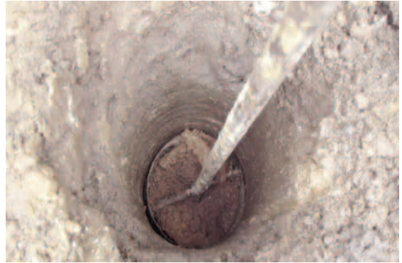
Gia cố nền móng công trình bằng công nghệ cọc khoan nhồi.
