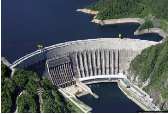
Đập thủy điện của nhà máy thủy điện Sayano - Shushenskaya (Nga)
