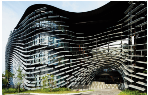
Các tấm quang điện được tích hợp vào mặt tiền tòa nhà Viện nghiên cứu công nghệ ITRI (Đài Loan), có chức năng đảm bảo tự chủ năng lượng đồng thời tạo hình ảnh độc đáo cho tòa nhà.
