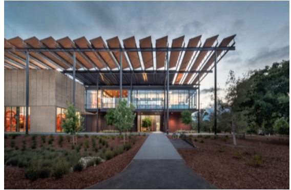
Central Energy Facility, Đại học Stanford là công trình tự chủ năng lượng đồng thời tạo hình kiến trúc độc đáo.
