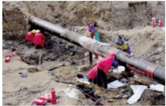
Khắc phục rò rỉ mạng lưới đường ống.
