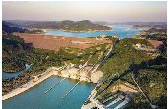
Gia cố đê kè ở lưu vực sông Hoàng Hà.
