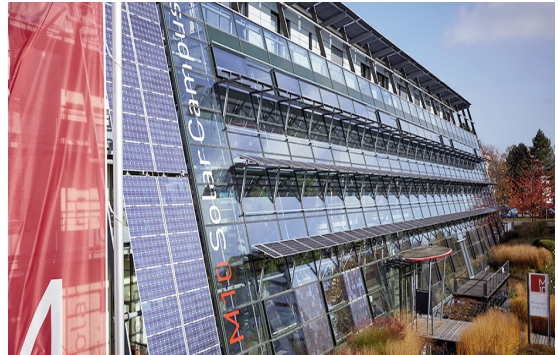
Các panel quang điện được lắp đặt trên mặt tiền khối nhà M10 Solar Campus.
