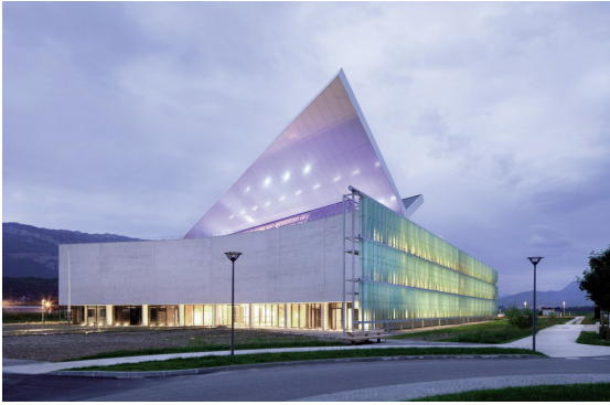
Mái dốc tòa nhà Viện Năng lượng mặt trời Pháp có góc nghiêng tối ưu để hệ thống quang điện được tích hợp trên mái tận dụng tối đa năng lượng mặt trời.
