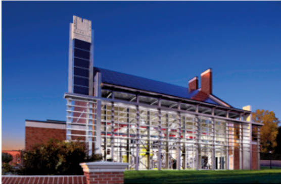
Tổ hợp Hemlock Semiconductor Building với tháp đồng hồ mặt trời, được bao phủ bằng các panel quang điện.
