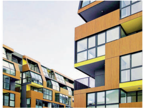
Mô hình nhà module sử dụng với mục đích nhà ở tại CH Liên Bang Đức
