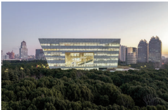
Thư viện Đông Thượng Hải - thư viện lớn nhất Trung Quốc
