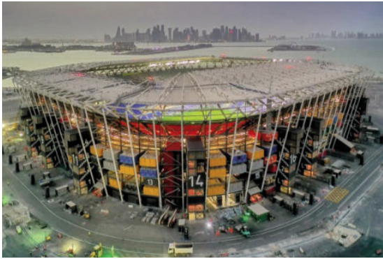
974 là sân vận động ở thủ đô Doha (Qatar) làm từ 974 chiếc container
